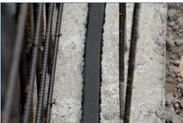
Verlegung mit Quellbandkleber
