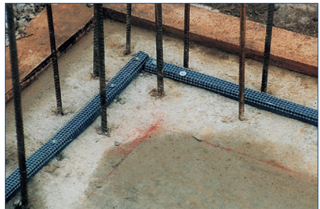
Verlegung mit Befestigungsgitter und Nägel
